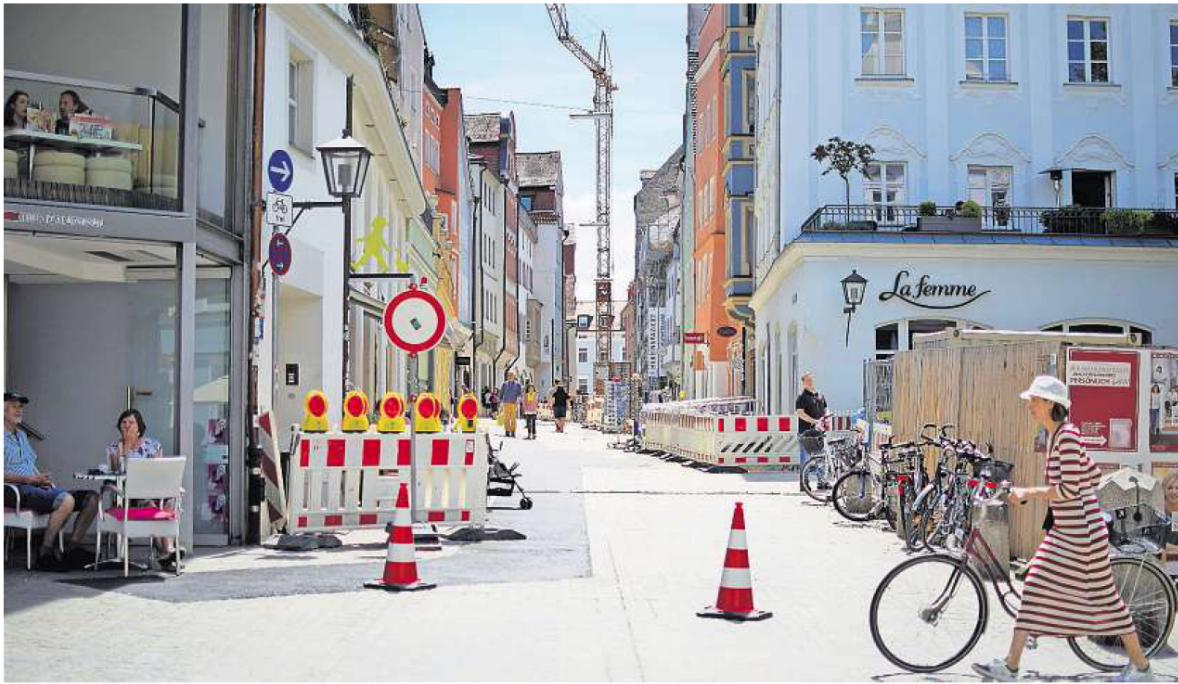
Die Wahlenstraße wird noch bis Ende des Jahres saniert.
